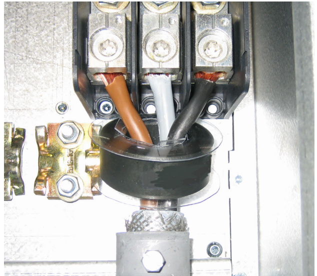
Fig. 55 Nucleo di ferrite montato sui cavi del motore
