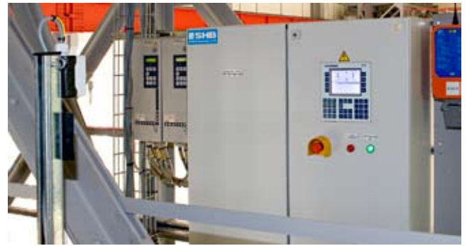
Das einzigartige elektronische Überwachungssystem garantiert vollsynchronisierte Laufkatzenfahrt. Die Auto-tuning-Funktion der Kransteuerung bedeutet, dass kein PC erforderlich ist. Die Parameter und Einstellungen werden deutlich angezeigt.
